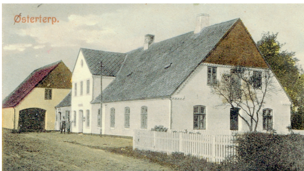
Billede af Øster Terp Kro fra omkring 1925. Amtsbanesporet er for længst fjernet. Der er stadig en postkasse opsat på kroens væg, mens selve postskiltet ses over døren. Købmandsbutikkens tidligere to vinduer er nu blevet erstattet med et stort vindue. Billedet af kroen er lånt i april 2015 af Jørgen Bendorff, Tønder.
