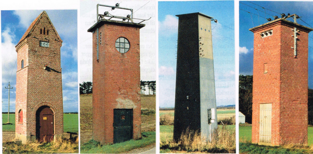
Nedenfor ses fire eksempler på forskellige udformninger på transformertårne.
